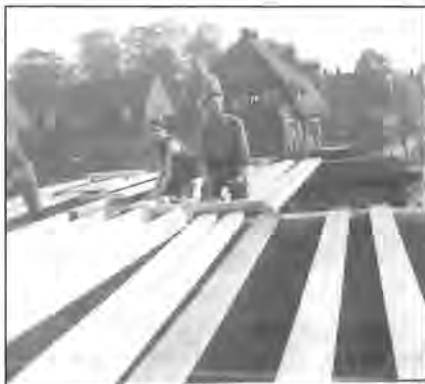
Afb. 1 In oktober 1953 wordt bij de eerste twee huizen de vloer van de eerste verdieping gelegd. Op de achtergrond de Nassaustraet, met in het midden het toenmalige café Huibers.
