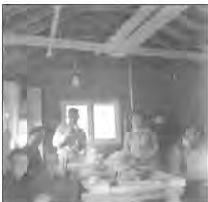
Afb. 2 Het gebouwtje bij het eerste dubbele woonhuis, bedoeld voor twee schuren, nog zonder tussenmuur. De ruimte werd zo in z'n geheel benut als schaft- en ontvangstlokaal.
