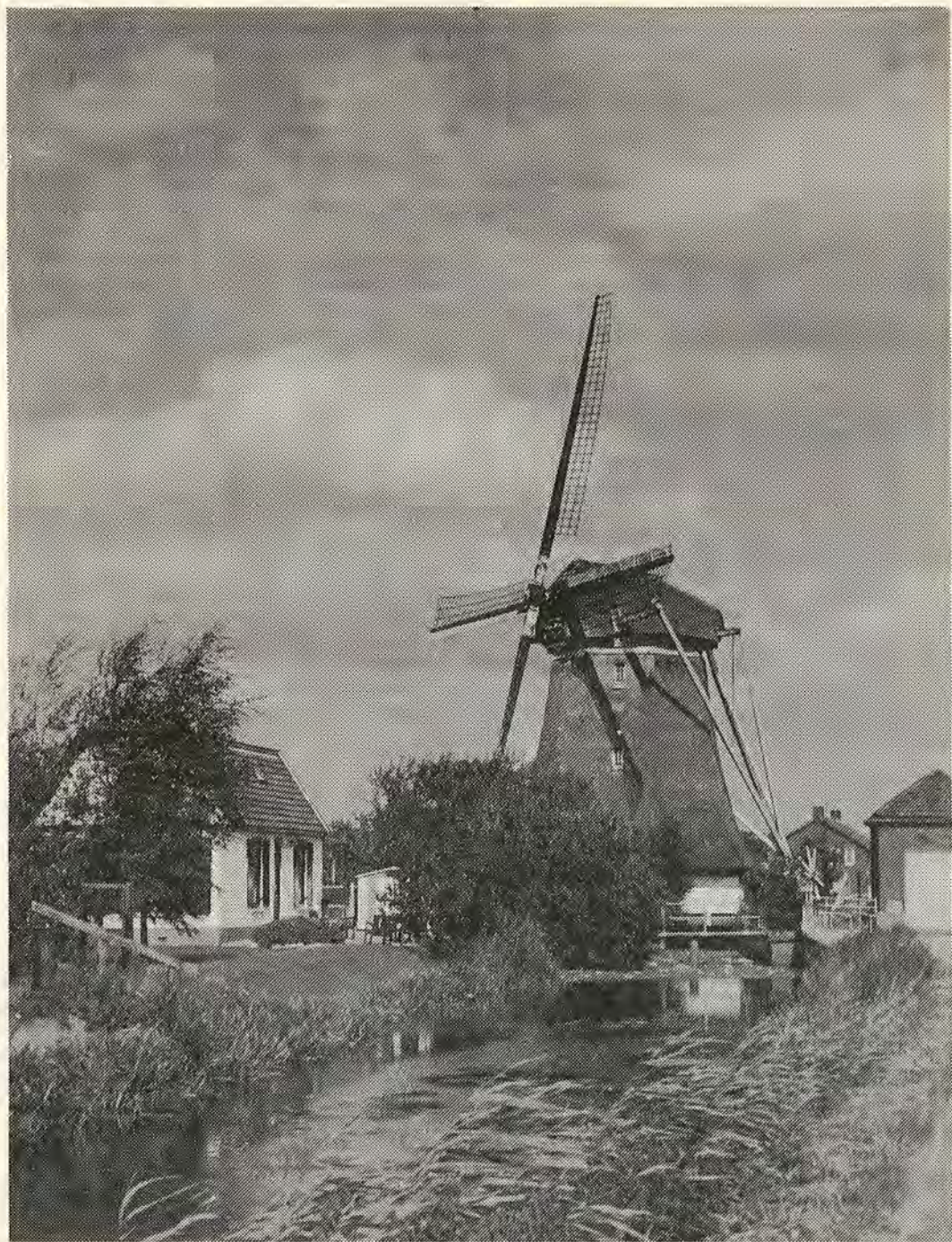
Poldermolen Westbroek (Oostwaard 2, Maarssen). Foto gemaakt door de Heer P. Oost uit Utrecht omstreeks 1975. Bij de laatste ingrijpende restauratie van deze achtkantige grondzeiler met vijzel in 1982-83 werd o.m. het imposante wiekenkruis totaal vernieuwd en kreeg de molen een modern soort fokwieken, ontwikkeld door Ir. P.L. Fauël. Deze fokwieken hebben de eigenschap dat ze ook zeer sterk trekken bij zwakke wind.
