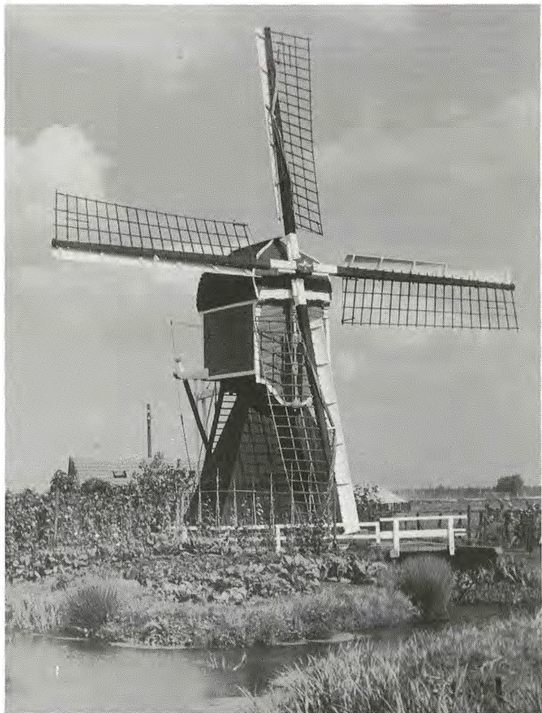
Poldermolen 'Oud-Zuilen'. Eén van de monumenten die op 12 september 1987 in de belangstelling zullen staan is de molen van het waterschap Buitenweg. Deze wipmolen, gebouwd ca. 1830, heeft een vlucht van 24 meter en heeft tot doel de polder Buitenweg droog te houden. Foto uit 1973, gemaakt door de heer Piet Oost te Utrecht.
