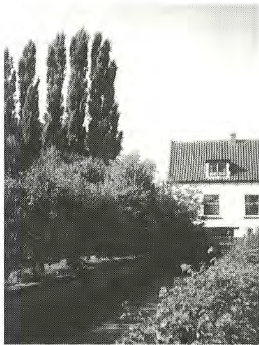
Sluishuis na de restauratie 1980-1982.
