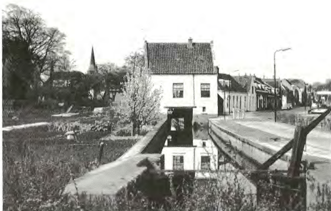
Sluishuis voor de restauratie 1980-1982.
