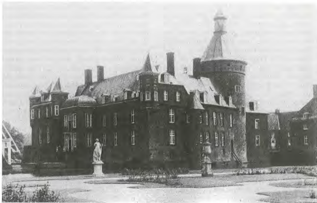
Slot Anholt gezien vanuit het noordwesten.
