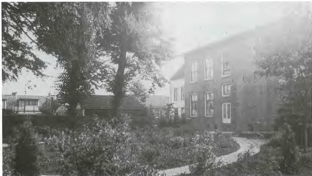
De linkerzijgevel anno 1992.
