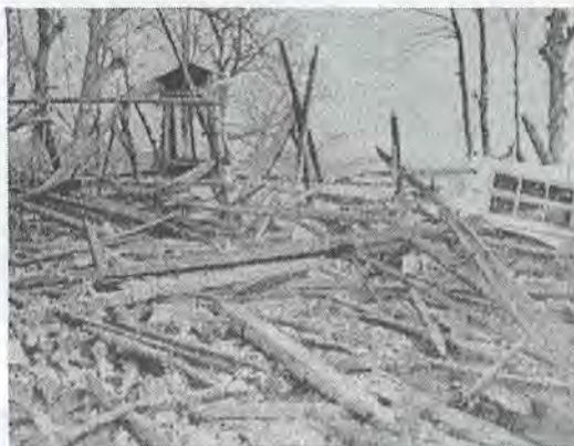
De resten van wat eens een statig dak was.
