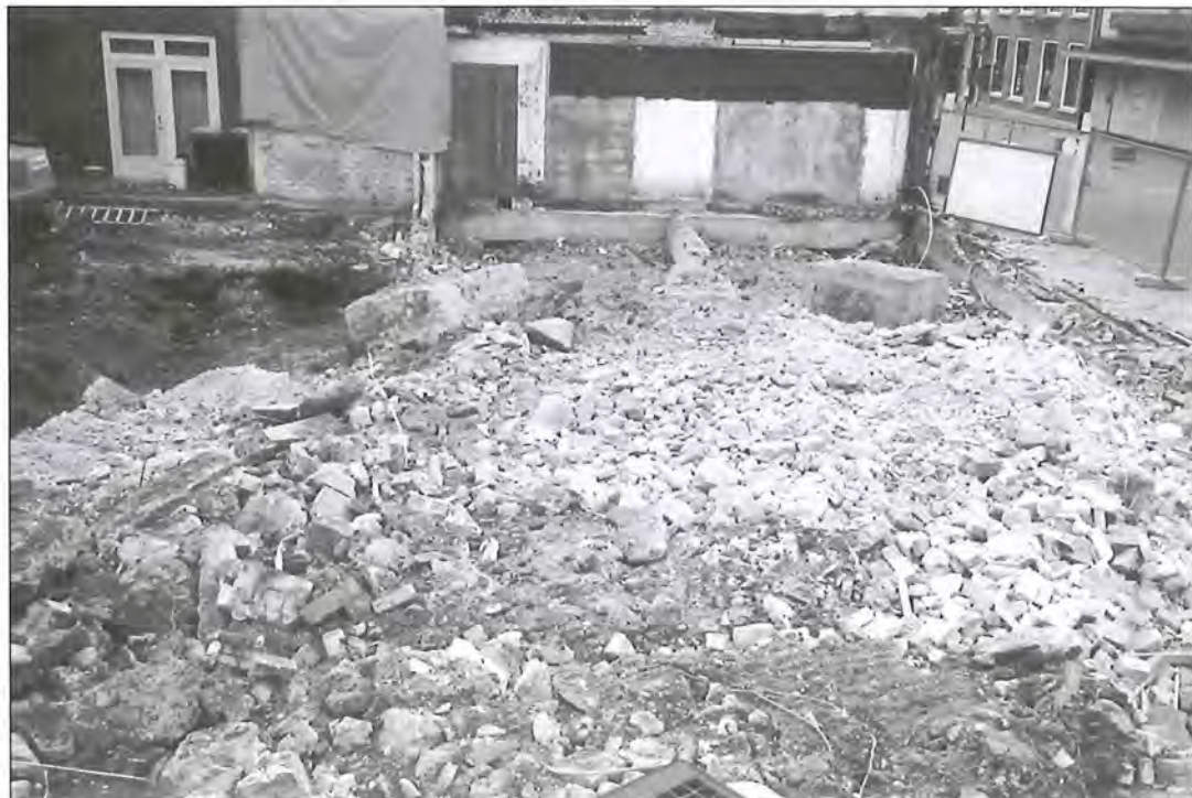
Foto 1. Door funderingspuin verstoorde bovengrond aan de Parkweg.
