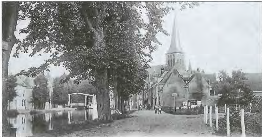
Hier een plaatje van de Wilhelminaweg waar goed op te zien is dat de muur van Bolenstein is afgebroken om de weg met de Schippersgracht te verbinden. Foto in bruikleen van H.G. Verkroost.
