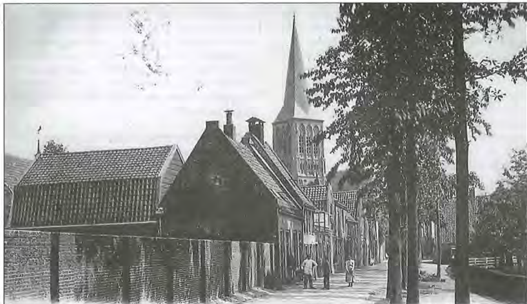
Afb.3. Een foto van omstreeks 1900. Waarschijnlijk bevindt zich achter de muur nog de moestuin. Aan de torenmuur van de op dit plaatje ongeveer vijftien jaar oude R.K.-kerk is de plek van de huidige wijzerplaten nog onbezet. Aan de kerktoeren waren in die tijd drie wijzerplaten bevestigd, die veel lager hingen en daarom op deze foto niet zichtbaar zijn. Gezien de grote werkplaats werd het eerste huis in 1900, evenals 240 jaar eerder door een ambachtsman bewoond. Uiterst rechts op de foto, waar zich nu de voorzijde van de nieuwe woningen bevindt, zijn enkele fruitbomen van de boomgaard van Kroon te zien. Het huis rechts is zijn boerderij.
