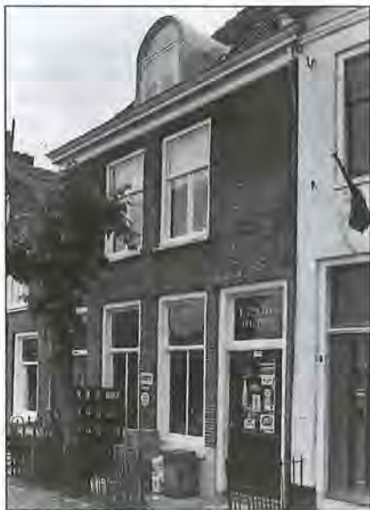
Foto van juni 1966 van de Langegracht 3/4. De melkwinkel was nog in vol bedrijf. Het pand heeft een 19e eeuwse lijstgevel, schuifvensters en een dakkapel. (foto archief gem. Maarssen)
