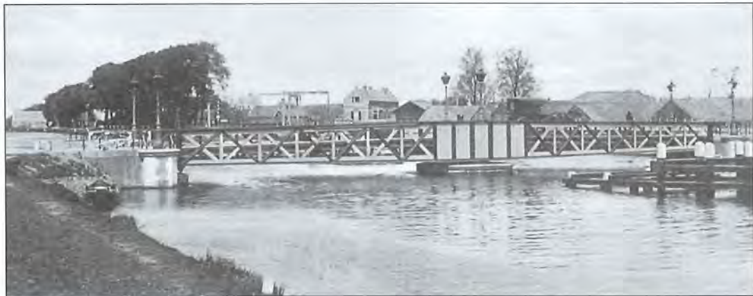
Afb.8. De fotograaf stond op de Westkanaaldijk voor de steenfabriek 'De Volharding' en hij fotografeerde in de richting van Maarssen. De brug was vooral bedoeld om de Zuilense en Maarssense boeren gelegenheid te bieden hun landerijen aan de westkant van het kanaal te bereiken. Vanaf 1911 verrijzen op de plaats van 'Welgelegen' rechts op de foto, de fabrieksgebouwen van de Kininefabriek. Het gebouw geheel links zou de boerderij Groeneveld kunnen zijn. Foto particulier bezit.
