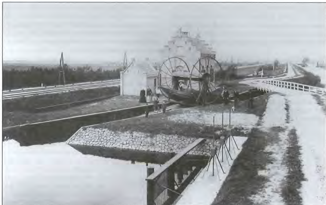
Afb.2. Overtoom. Kleine vaartuigen, zoals boerenpramen en schouwen werden over de afsluitdam 'getrokken' met behulp van een wipmechanisme. De overtoom bevond zich waar de Haarrijn het Merwedekanaal bereikte. Rond 1900 is de overtoom al buiten dienst gesteld. De woning van de overtoomwachter staat nog aan de Westkanaaldijk. Foto Utrechts Archief.
