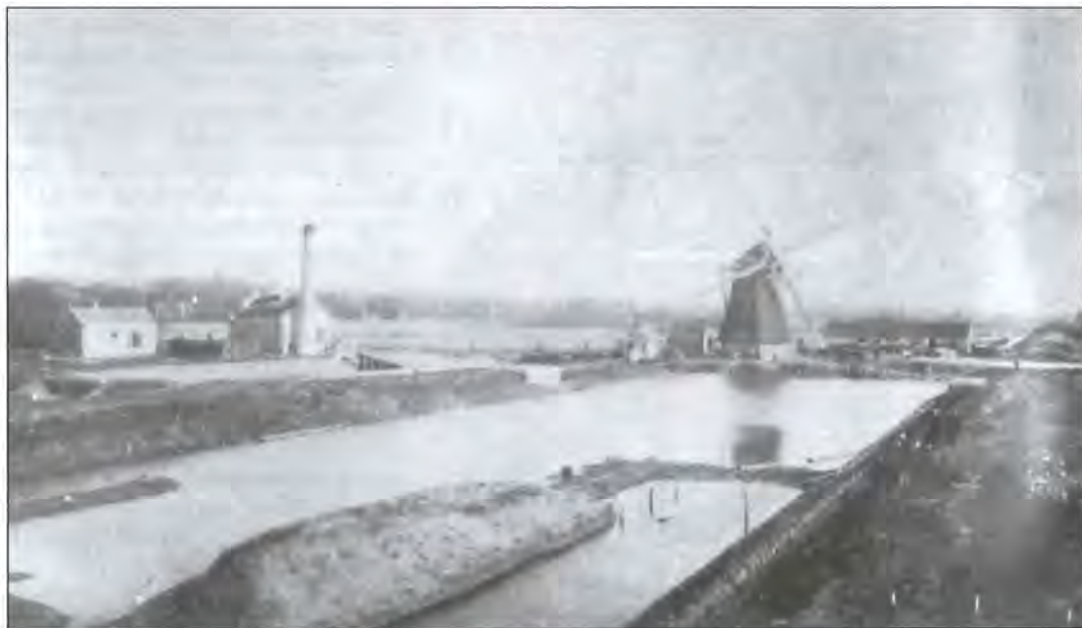
Afb.4. Op deze bijzondere foto uit 1890, die werd genomen vanaf de Westkanaaldijk in de richting van Maarssen-dorp is het kanaal nog niet in gebruik. Het stoomgemaal voor de polder Maarssenbroek op een voormalig stuk grondgebied van Hertevelt staat er al. Aan de linker- en rechteroever is aan de stenenvoorzieningen te zien waar de pijpleiding liep. De molen bleef nog enige tijd gespaard; de Zeijlweg kon nog niet doorgegraven worden omdat de draaibrug bij de Stationsweg nog niet klaar was.
