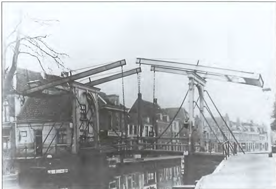
Afb. 3: De brug zoals deze heeft dienst gedaan van 1823 tot 1936. In dat laatste jaar is in verband met de toename van het wegverkeer gekozen voor de oplossing zoals deze nu nog is. Er is toen ook een nieuwe brugwachterswoning gebouwd om de toegang tot de Schippersgracht te verbreden.
