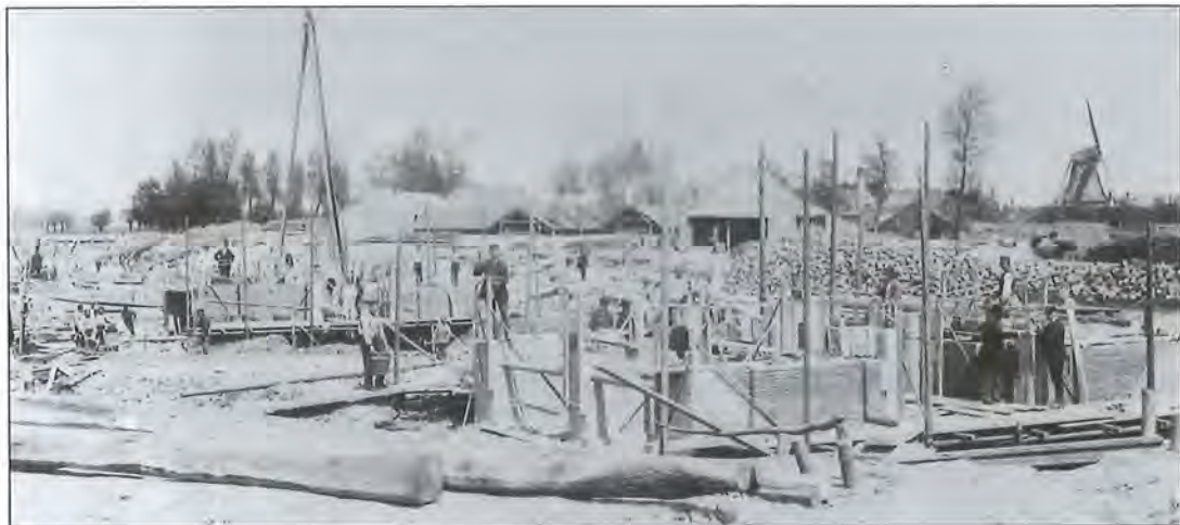
Afb.11. Volgens de eigenaar van de foto, de heer C.W.P. Bloemendaal, wordt hier de sluiswachterswoning bij de Vechtsluis gebouwd. De bouwplaats doet inderdaad denken aan de situering van deze woning. In de vorm van de bouwsels is nog moeilijk de sluiswachterswoning in wording te herkennen. Op de achtergrond zijn schuren van de dakpannenfabriek 'Welgelegen' en heel mooi de molen van De Ridder te zien.
