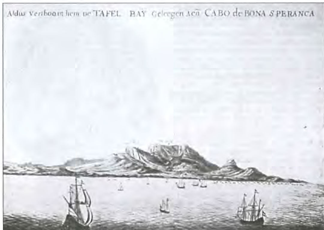
Afb.4. Kaap de Goede Hoop ± 1655. Naar een waterverftekening uit het rijksarchief te Den Haag. Dit is de oudst bekende afbeelding van de nederzetting aan de Kaap. Er stonden alleen een fort en enkele woningen voor het personeel.
