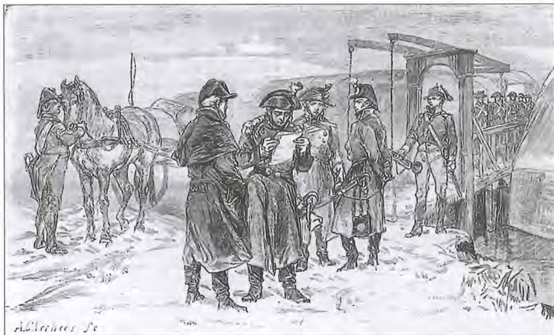
Afb. 10. Krayenhoff bij het fort Nieuwersluis. A.C. Verhees, Tijdschrift Eigen Haard , 1888, blz.9.
