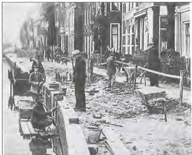
Een belangrijk werk wordt te Maarssen uitgevoerd, n.l. het aanleggen van een rioleering en de verbreding van de kade op de Langegracht: de kade, die hier en daar slechts 1 m breed was, wordt nu op een breedte van 4 m gebracht. (De Keyzer)
