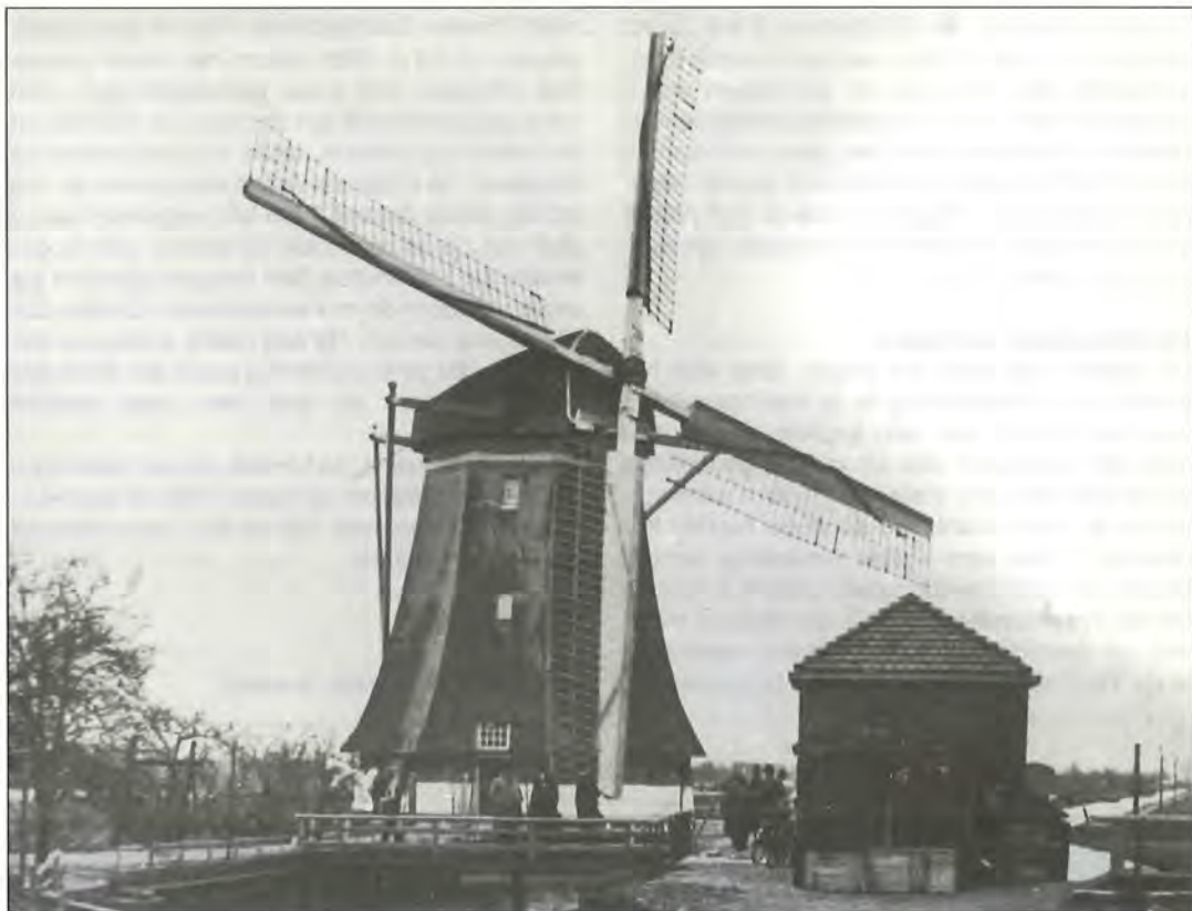
Afb 8. De molen draait proef na in gebruik stellen door Ir. A. Mussert, destijds Hoofd Ingenieur van Provinciale Waterstaat Utrecht.
