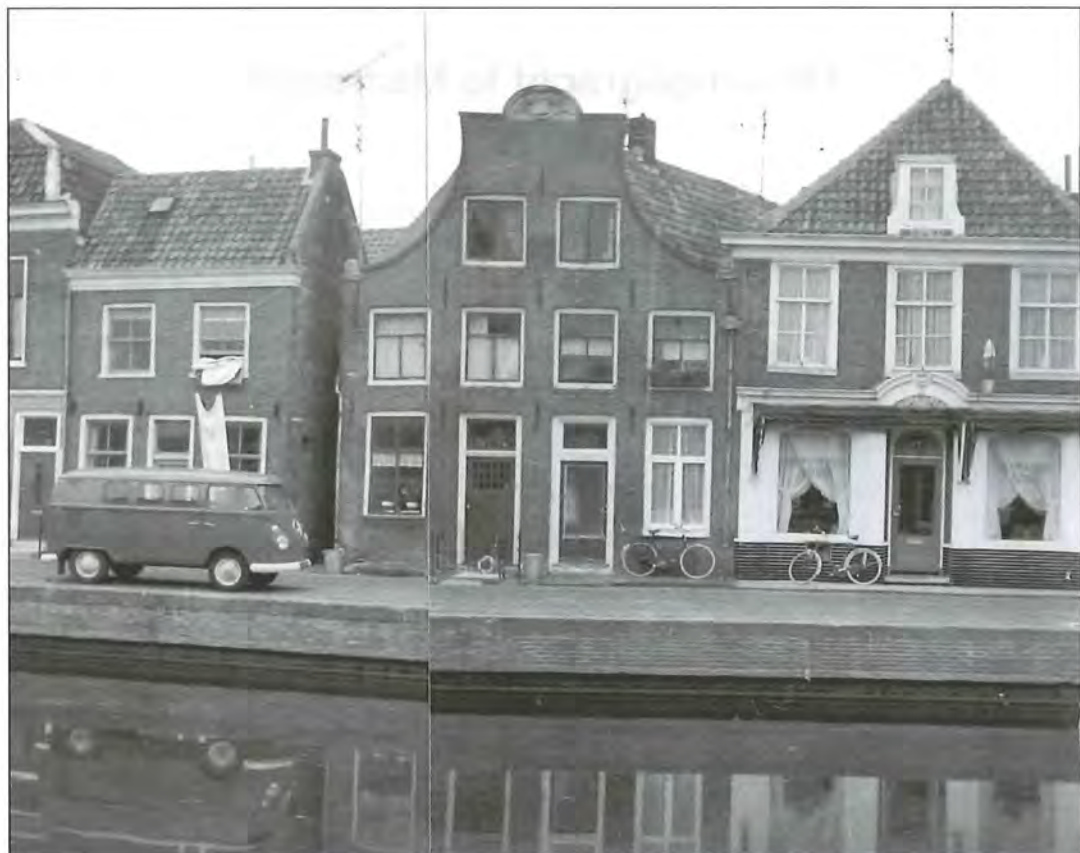
Afb. 2. Langegracht 37 en 38 vlak voor de verbouwing.
