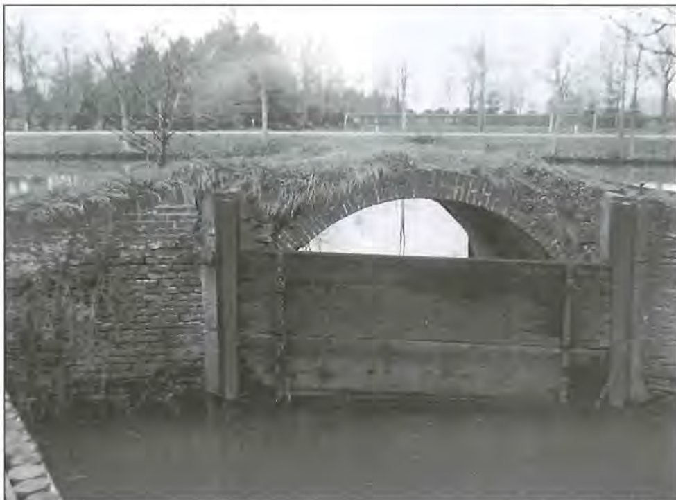
Afb.4. Toen de sluisdeuren versleten waren, is waarschijnlijk na de Tweede Wereldoorlog gekozen voor deze goedkopere oplossing aan de andere zijde van de brug. De staande gedeeltes, waar de schotten in werden neergelaten en werden opgehaald, bevinden zich nog aan de brug.
