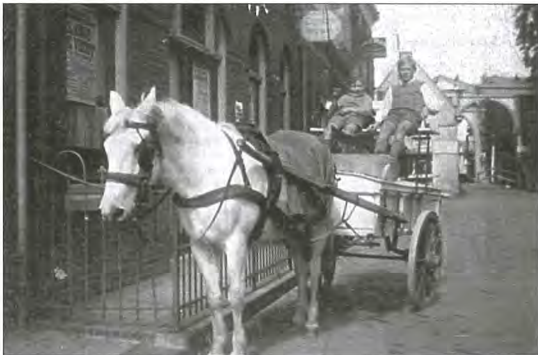
Afb.3. De Breedstraat in 1930, gebouw Concordia staat links op de foto.
