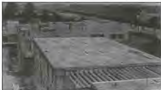
Afb. 5 Het Centrum in aanbouw in juni 1966, ongeveer een jaar voor de officiële opening.
