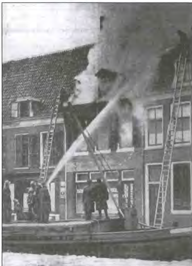
In het perceel Langegracht 44 te Maarssen, waarin een boekhandel is gevestigd, ontstond hedenmorgen brand. Hierboven een foto van het blusschingswerk, dat geruimen tijd in beslag nam.
