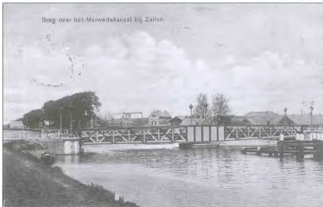
Afb. 3 De draaibrug over het Merwedekanaal die de verbinding tussen de Kantonnaleweg en de Straatweg moest blijven verzorgen. Een gelijksoortige brug maakte een verbinding van de Stationsweg naar het treinstation van Maarssen. In het midden de ophaalbrug over de Straatweg, daarnaast het nog bestaande brugwachterhuis. Rechts in het midden de pannenfabriek 'Welgelegen', later de Kininefabriek. Dagstempel van de kaart, 12 augustus 1909, collectie Museum Maarssen.
