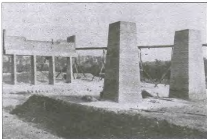
Afb. 1 In 1937 werd begonnen met de bouw van de nieuwe brug. Op de afbeelding zijn pijlers en landhoofden al klaar. Foto uit collectie van Hans van Bommel.
