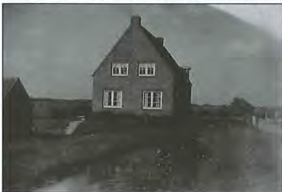
Het karakteristieke huis met het gemaal, nog niet ingesloten door bebouwing van de nieuwe wijk.
