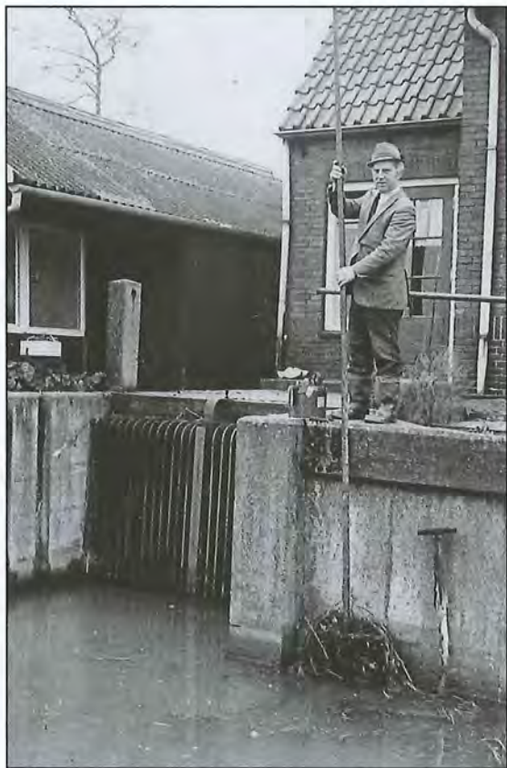
Met de hand viste ik regelmatig het vuil uit de inlaat van het gemaal.
