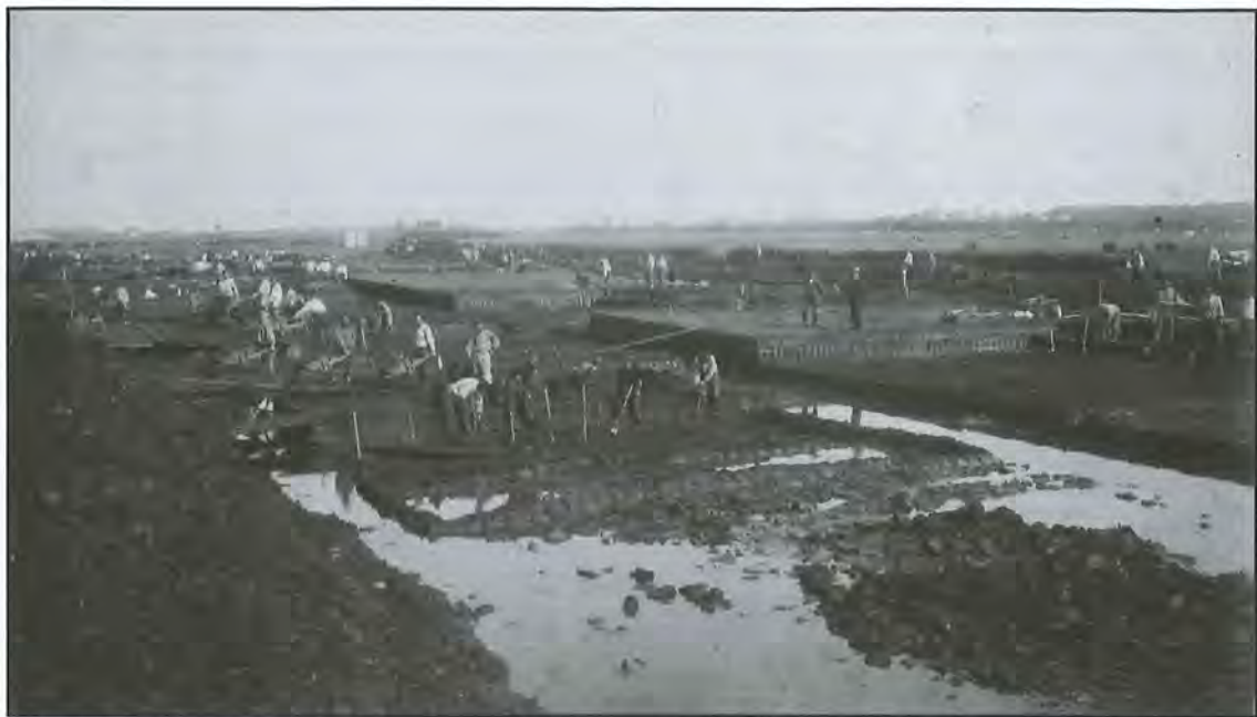
Afb. 2 Graafwerkzaamheden voor de aanleg van het Merwede-kanaal bij Breukelen, mei 1889. Rechts aan de horizon zijn de kerktorens van de Hervormde en de Rooms-Katholieke kerk van Breukelen te zien.
