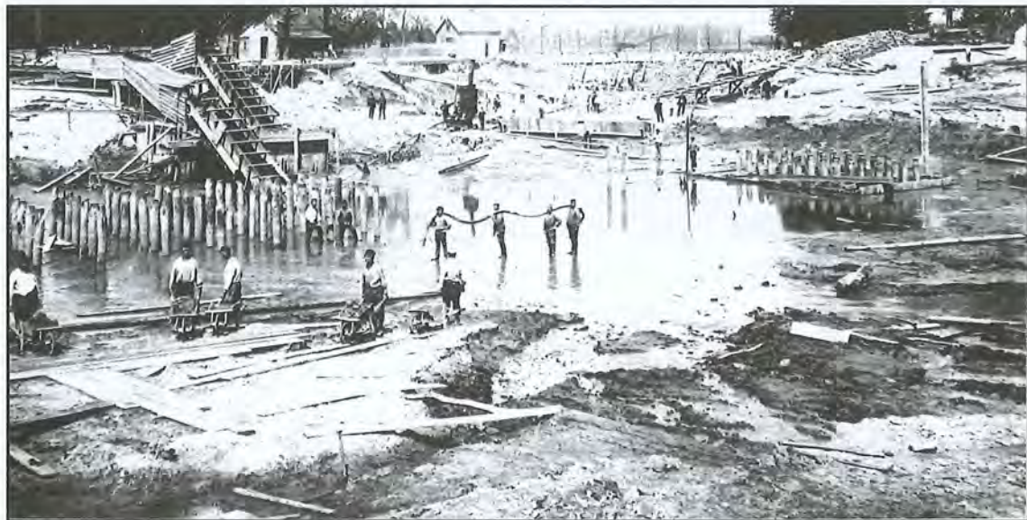
Afb. 3 Werkzaamheden aan het sluizencomplex in Maarssen tussen de Vecht en het Merwedekanaal. Op de achtergrond de polder Oostwaard, net zichtbaar is een rolpaal aan de Vecht.
