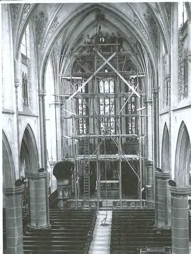
Afb. 4 Deze afbeelding, ca.1950, laat duidelijk zien dat van beide preekstoelen er één is samengesteld. De bouwsteiger was nodig omdat één van de bogen dreigde in te storten. Op de steiger ondermeer de heren Brinkhof, Van den Engel, Van Fulpen en Jan Slager. Zij hebben de reparatiewerkzaamheden uitgevoerd. (Afb. Heilig Hart Parochie).
