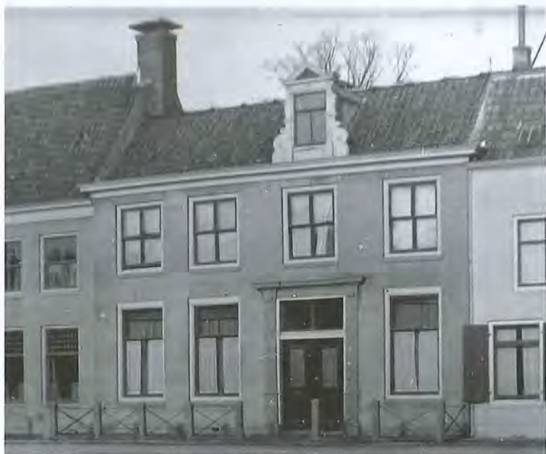
Afb. 7 In dit huis, De Domstoren, hebben de grootouders van mgr. Ariëns gewoond. Het huis, Herengracht 18, is in 1707 gebouwd.
