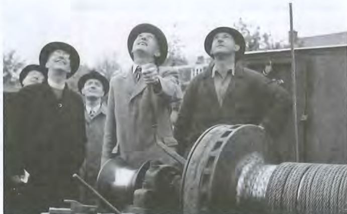
Onder toezicht oog van de heibaas slaat burgemeester De Ruiter de eerste heipaal in de grond. Links op de voorgrond pastoor Jansen. Rechts van hem architect Van Gendt. Over de rechter schouder van de pastoor kijkt ook kapelaan Van 't Klooster mee.
