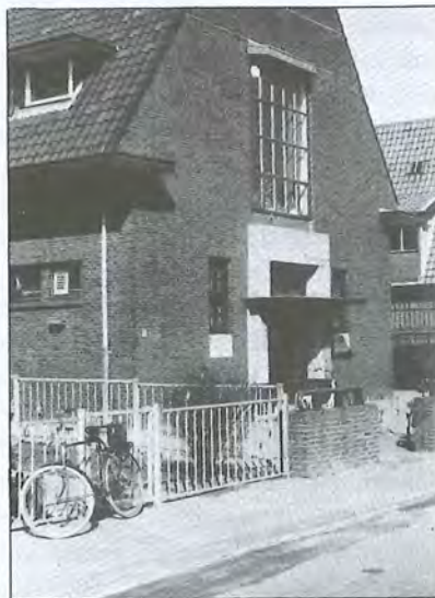
Het gymnastieklokaal aan de Gaslaan.
