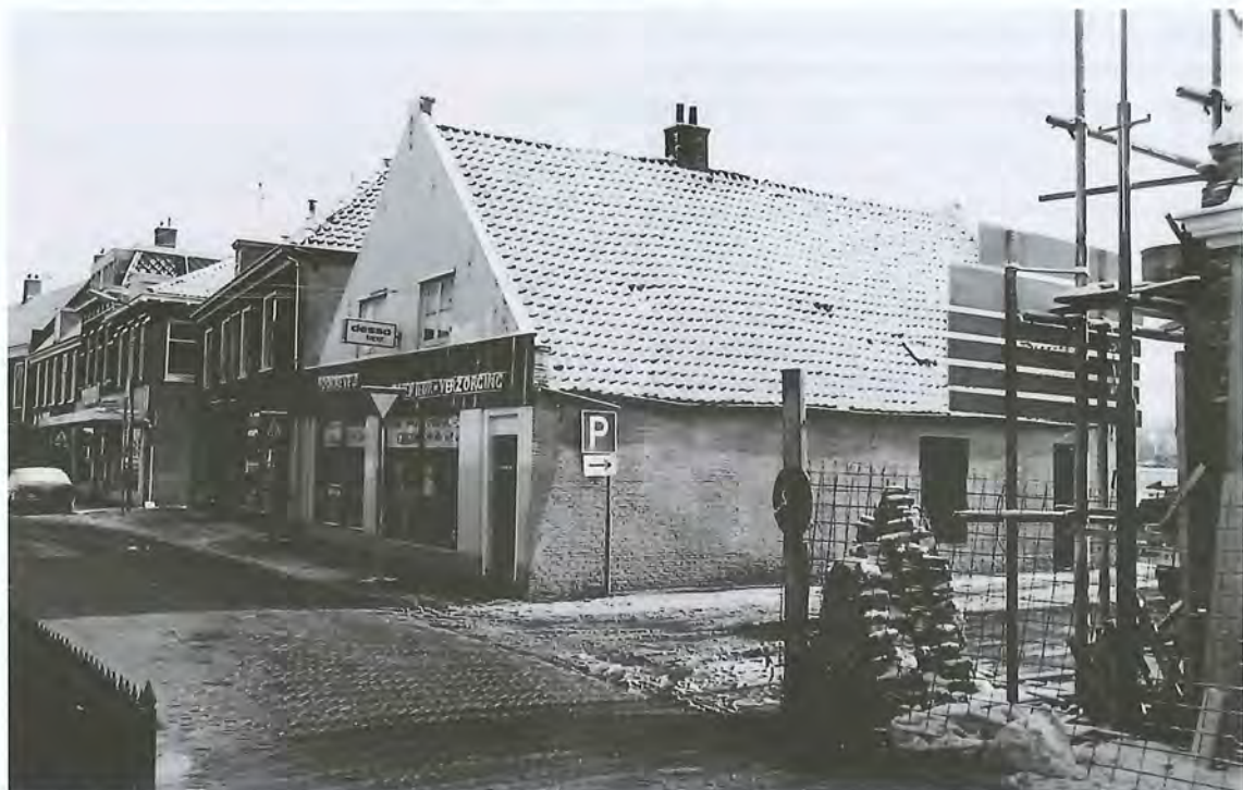
Aan de Bolensteinsestraat het te slopen pand met er naast Okkerman en Reith.
