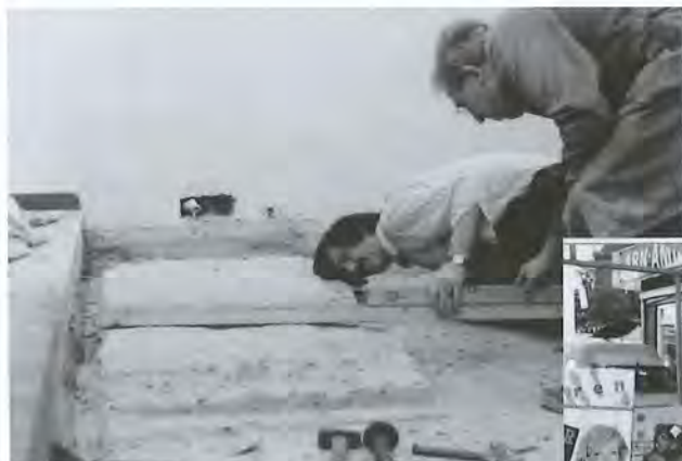
Afbeelding 16 Adrie van Petten (allround vakman, sinds 1990 vrijwillig klusser) is hier bezig samen met Arie de Zwart (vrijwilliger sinds 1991) in de grote zaal de twee niveaus van de vloer met 30 cm. hoogteverschil, te voorzien van een tussenniveau van 15 cm. hoogte, waardoor voor een flinke groep bezoekers een beter zicht op het podium zal ontstaan. In 1993 werd de klusgroep uitgebreid met Benno Visschedijk en in 1997 sloot Arie Domburg zich aan.
