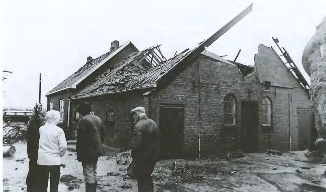
Afb. 1 Woonhuis Oudhof met veel schade aan de stal.
