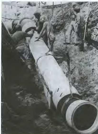
Afbeelding 7: Minder spectaculair, maar daarom niet minder belangrijk, was de aanleg van de riolering in Maarssenbroek. Ter hoogte van de Kantonnaleweg werd in de zomer van 1973 hard gewerkt aan de aanleg van de zogeheten effluentleiding, de buis waardoor het gezuiverde rioolwater zou worden afgevoerd naar het Amsterdam-Rijnkanaal.
