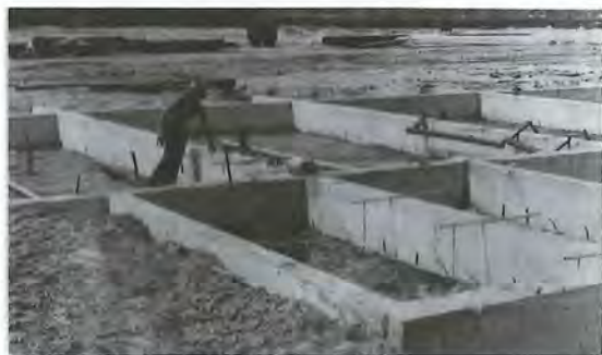
Afbeelding 4: In de zandwoestijn die het zuidelijk deel van Maarssenbroek toen nog was, begonnen in de zomer duidelijk de contouren van de eerste huizen zich af te tekenen. Toen de eigenlijke bouw in september werd gestart, waren op dat moment de funderingen van ruim 50 huizen gereed. Het plan was om, als er zich geen al te grote tegenslagen voordeden, de eerste woningen eind december klaar te hebben.
