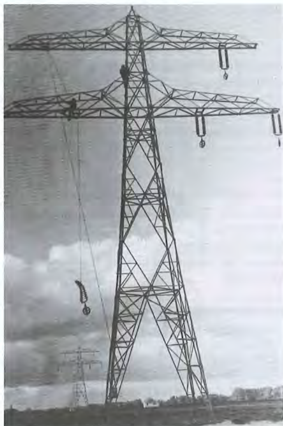
Afbeelding 3: Twee technici zijn bezig met kabelwerkzaamheden (Foto Jan J. van Dijk).
