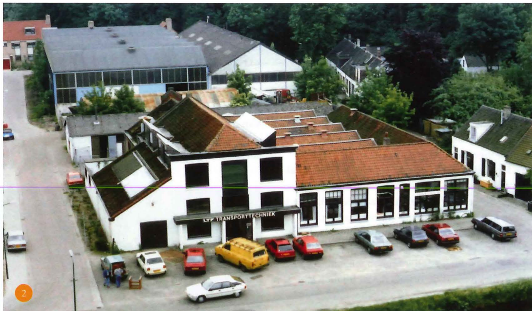
De LTF vanaf de Zandweg gezien.
