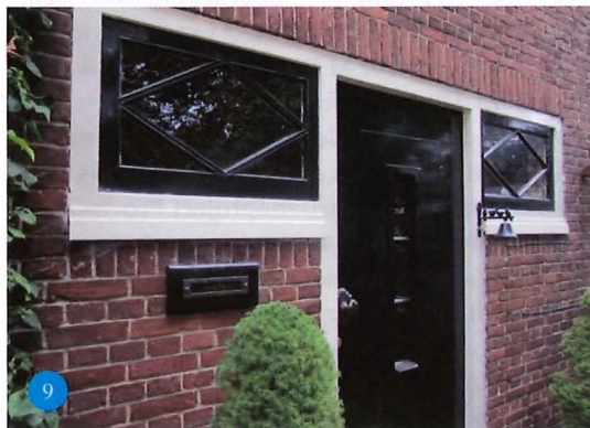
Detail van de entree van Binnenweg nr. 68. Foto: J. Simonis
