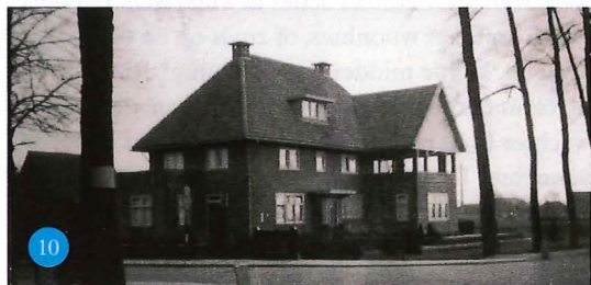
Notariswoning en -kantoor Kerkweg nr. 43, ontworpen in 1923, gebouwd in 1924. Bron: Archief mevrouw E. Wijmstra-Mencke, foto uit 1924
