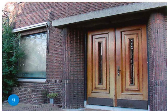
Afbeelding 9: Hoofdentree in de rechterzijgevel. Let op de prachtige baksteen verbanden, typisch voor de Delftse school. Foto: DSM Minerva bv
