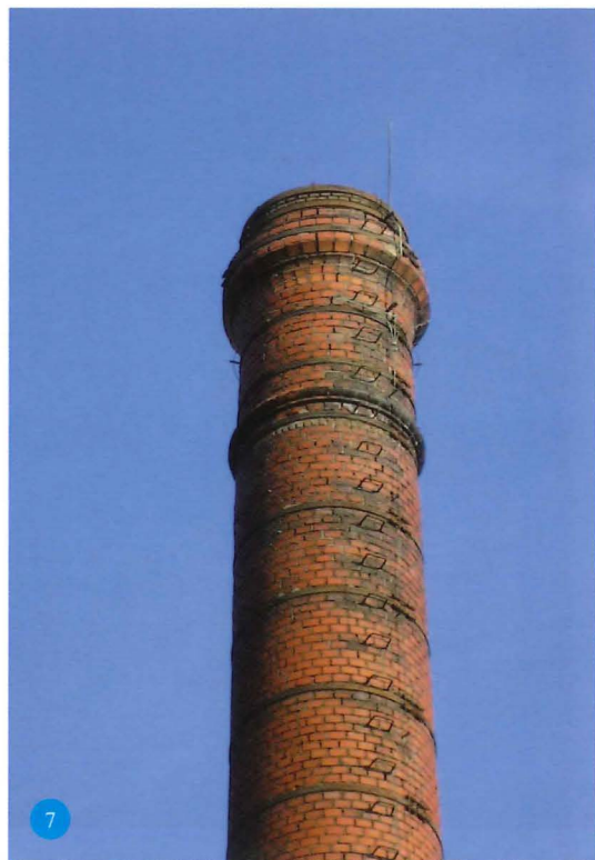
Uitkragende kop met uitspringende sierrand.
