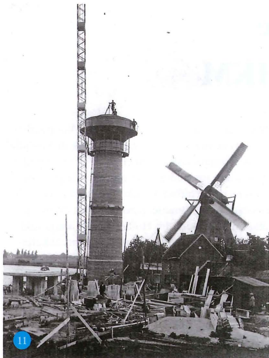
Het plaatsen van het waterreservoir rond de schacht van de schoorsteen in aanbouw. (In bruikleen van de erven C.W.P. Bloemendaal)
