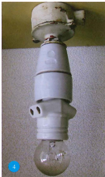
Lampfitting met lasdoos voor bevestiging aan plafond. Waarschijnlijk afkomstig van sloop woning of boerderij aan de Laan van Niftarlake in Tienhoven. In bezit van auteur. Schenking N. Hogenhout-Hofman.
