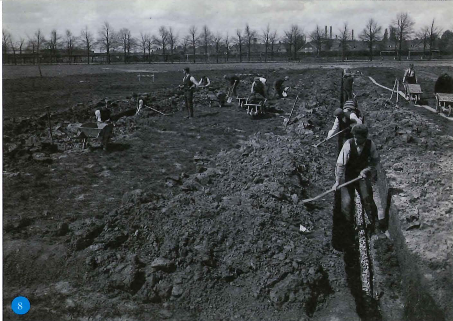
Het graven van een drainagesleuf door jongeren in de werkverschaffing. Foto Jochmann Disco, 1935. Beeldbank HUA, cat.nr. 42336.
