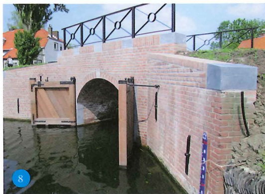
Foto van de nieuwe brug met sluisdeuren en peilschaal.
