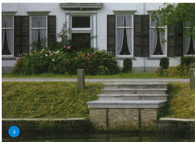
De gerestaureerde waterstoep voor Herteveld met rechts en links de herstelde dakpanbeschoeiing. Foto: Steven de Clercq.
