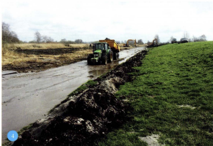
Een werkpad van 3000 rijplaten.
